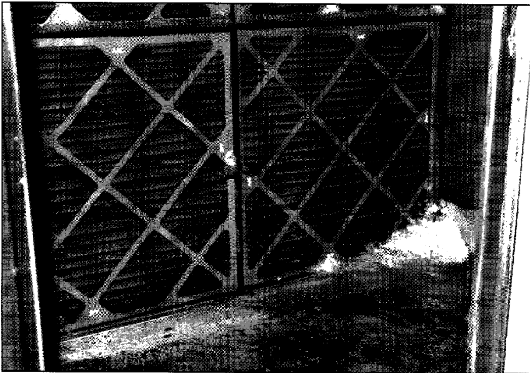
Figure 3.4: Filtres endommagés par les conditions environnementales extérieures
