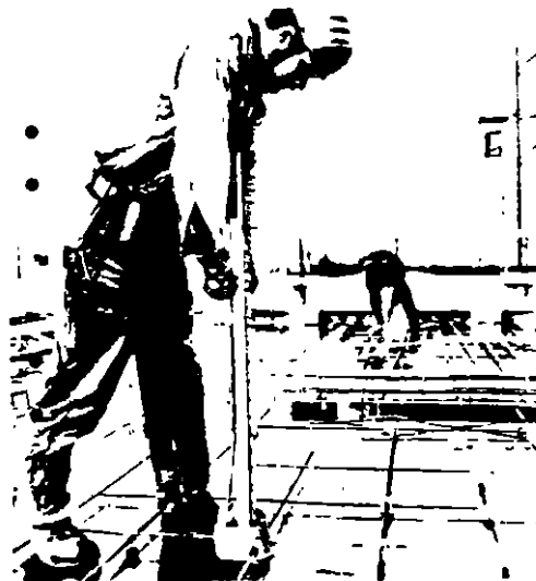
Fig. 4.5 Outil pour brocher les armatures
