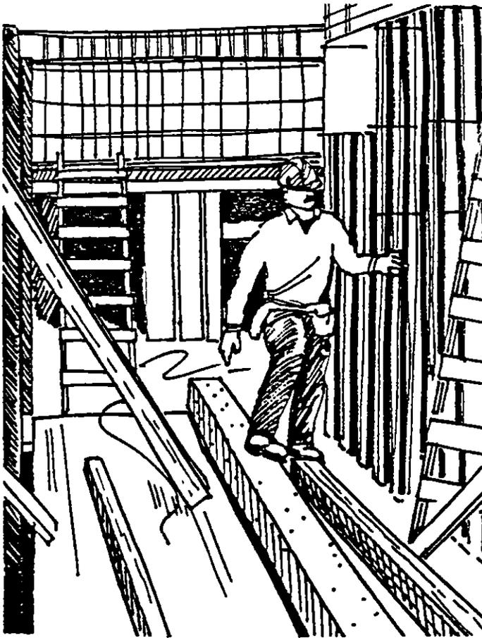
Figure 12: Poutre de béton au centre de la cage d'escalier empêchant l'utilisation d'un échafaudage et gênant les déplacements.
