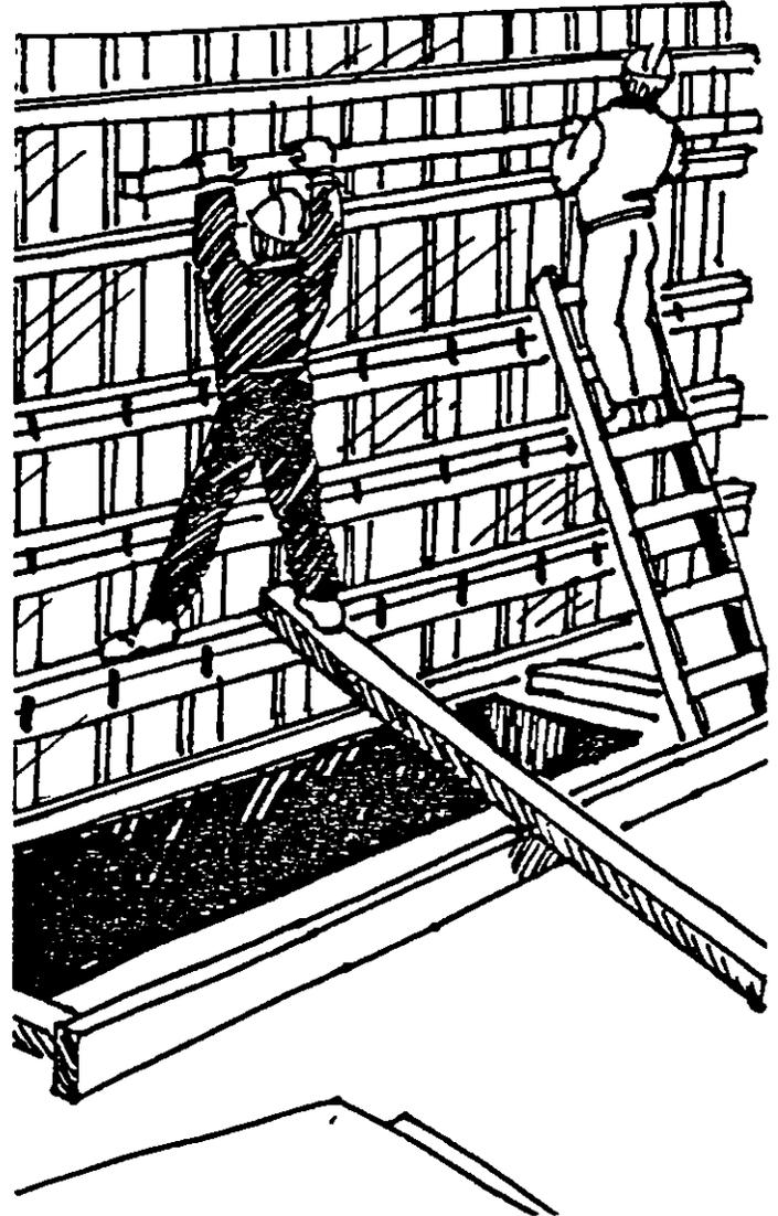
Figure 7: Charpentier-menuisier en appui sur une plate-forme de madrier.
