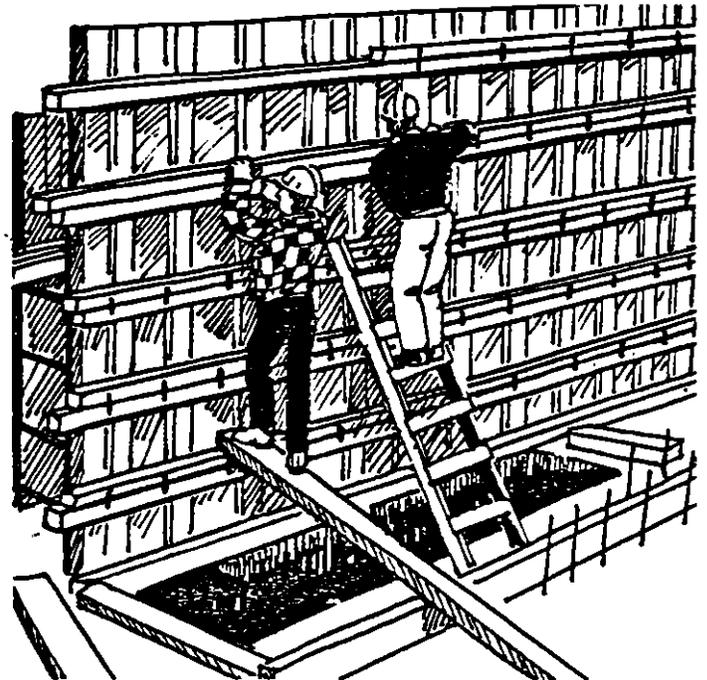
Figure 13: Difficultés de travail au-dessus de l'ouverture d'accès à la dalle.
